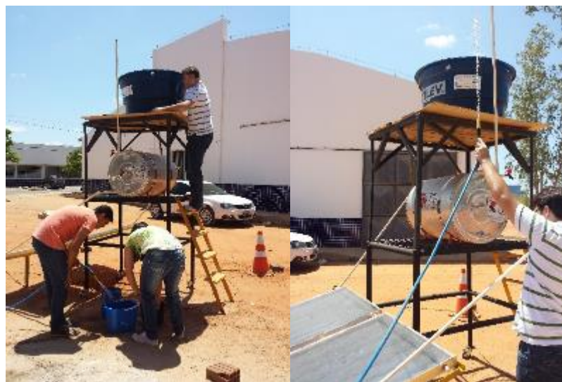
Figura 6: Enchimento da caixa d'água para realização de testes de estanqueidade Fonte: BRANCO, 2015
