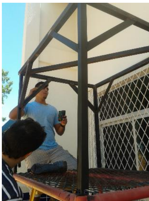
Figura 4: Pintura da parte superior da estrutura Fonte: BRANCO, 2015
