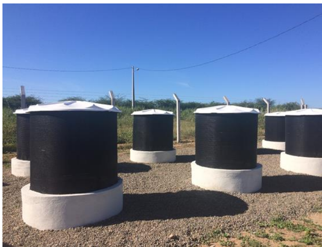
Figura 6 - Usina de compostagem da UFERSA campus Mossoró
